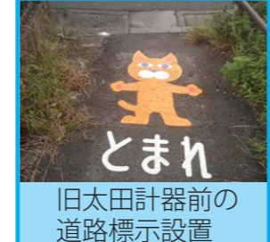
(株)コーザイ横の道路補修
