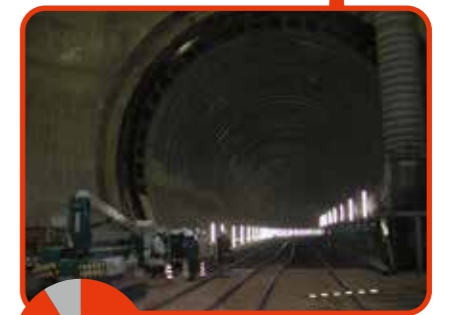
環状7号線地下調節池 493,500㎡ (約91%)
